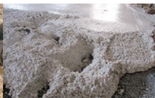
BÉTON DE CHAUX
