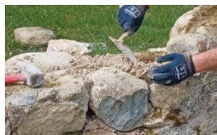
MONTAGE DE MURS
